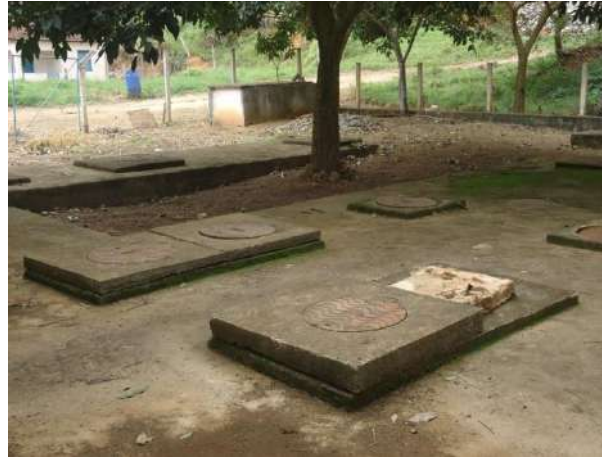
Figura 18 - Estação de Tratamento de Esgoto - Fossa-Filtro (Sede)
