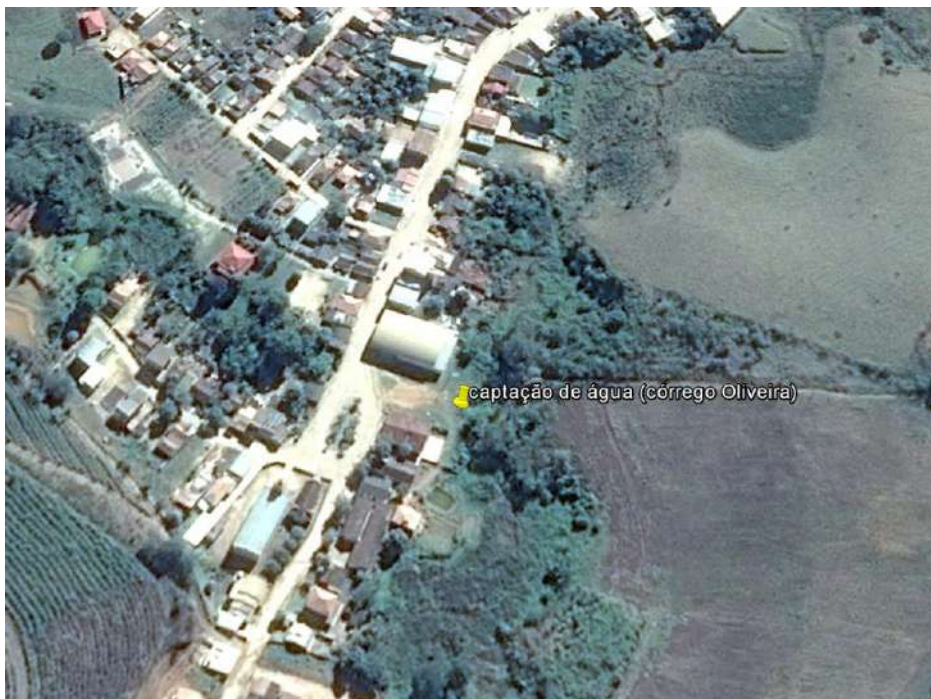
Figura 10 - Vista panorâmica do local de captação de água do distrito de São Jorge (córrego Oliveira)
