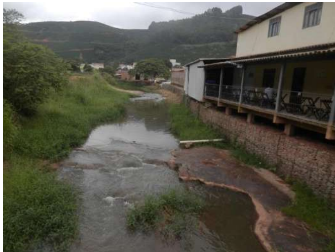
Figura 31 - Visão de montante da ponte 2.
