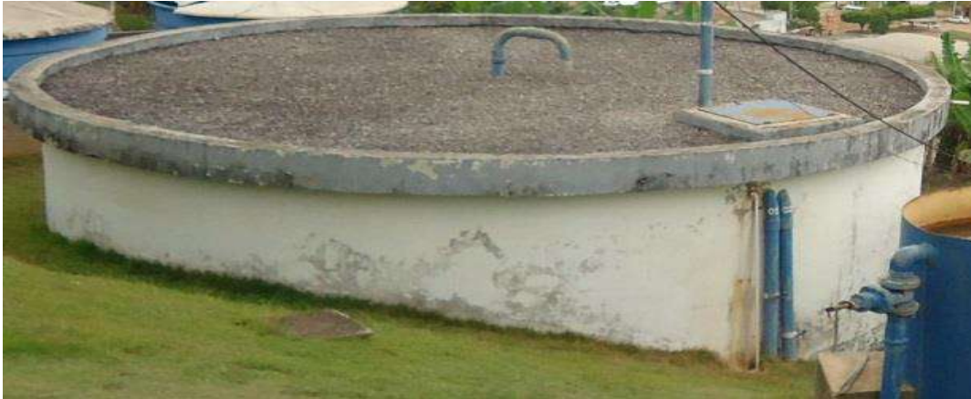
Figura 3 - Reservatório de abastecimento público (capacidade - 100 m 3 )
