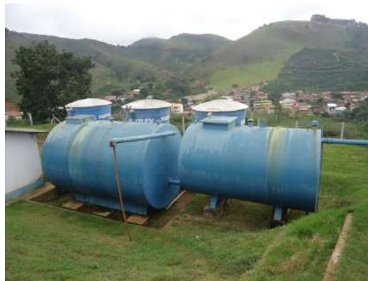
Figura 6 - Reservatórios de abastecimento público - São Jorge (capacidade total 90m 3 )
