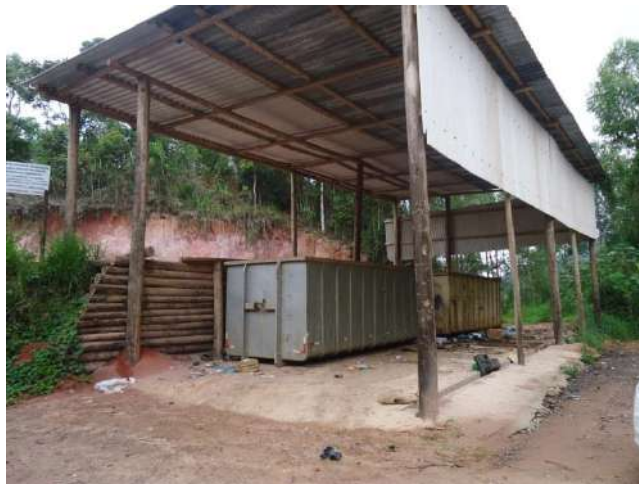
Figura 56 - Área de transbordo dos resíduos sólidos da coleta regular
