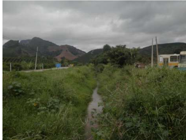
Figura 28 - Visão de montante da ponte 1
