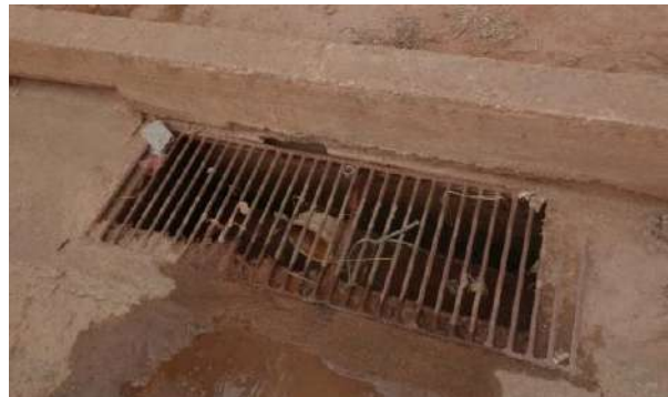
Figura 42 - Detalhe da rede de drenagem
