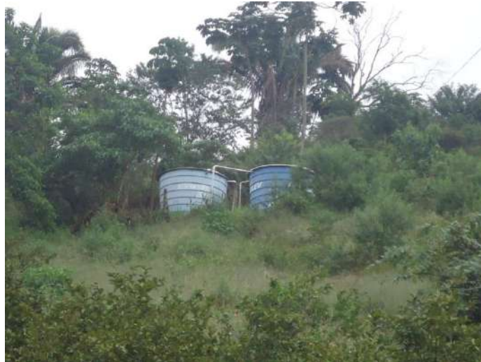
Figura 9 - Reservatórios de abastecimento público - Vila da Amizade (capacidade - 20 m 3 cada)
