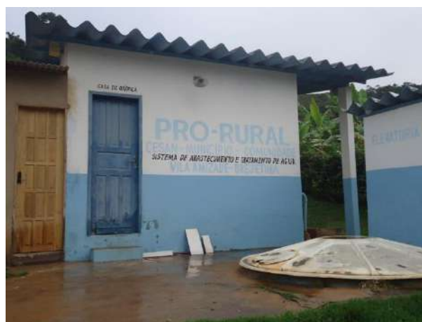
Figura 7 - Estação de Tratamento de Água - Vila da Amizade
